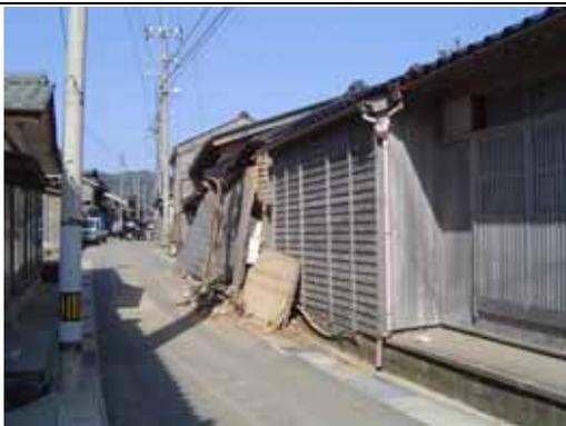
外壁板壁内の土壁崩落
